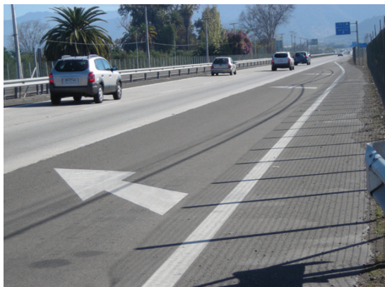
Las flechas en la calzada le indican que debe abandonar la pista de aceleración e incorporarse al resto del tránsito.
