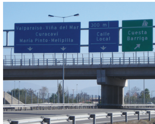
Las señales de tránsito informativas colocadas en altura sobre la calzada facilitan la selección de la pista correcta.
