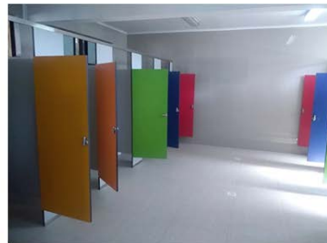
Tabiques y piezas sanitarias
