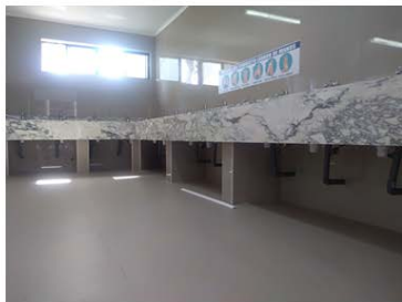
Lavamanos bajo cubierta, lámparas
