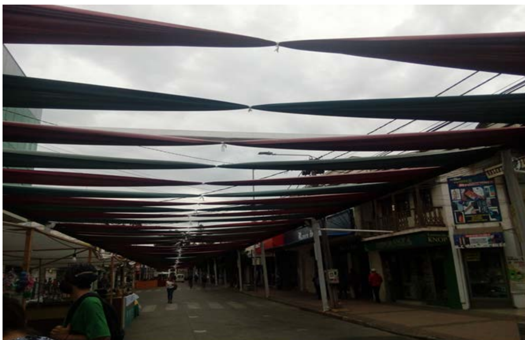
Apoyo a la adecuación de Toldos en periodo de lluvia.
